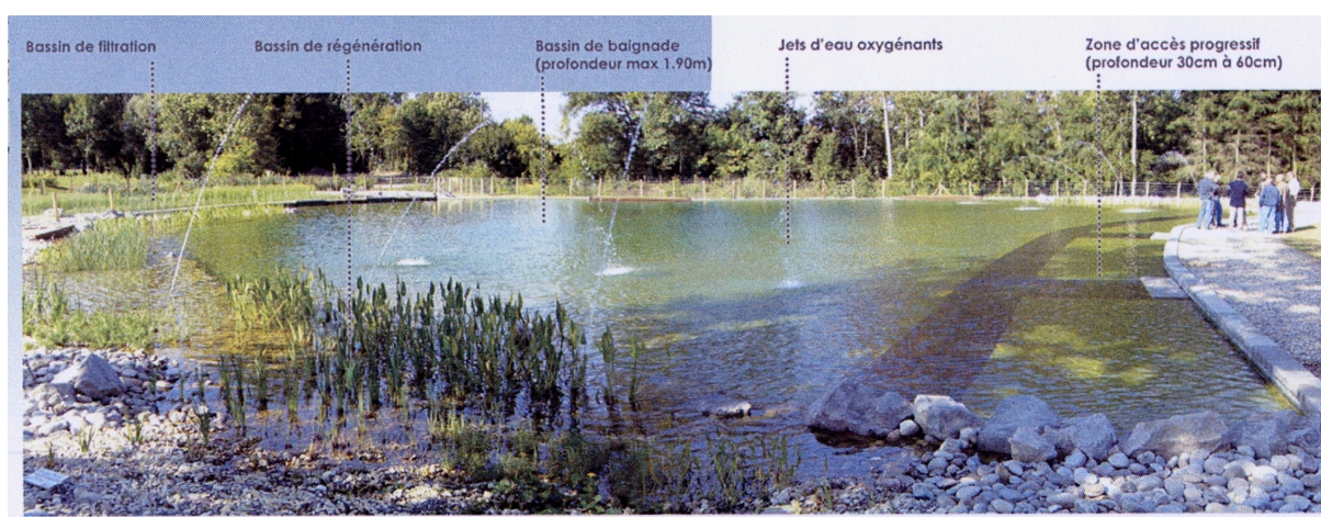
Le bassin de baignade vu depuis la zone de régénération
