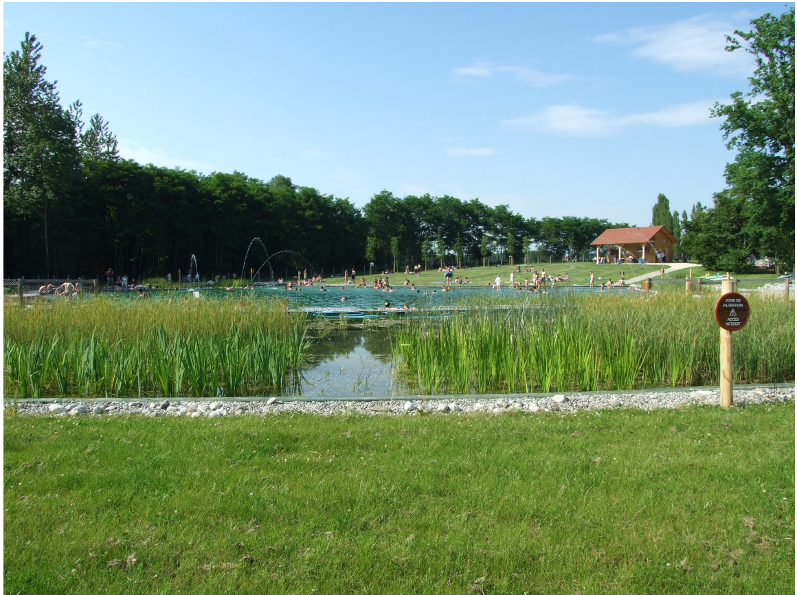
La zone de filtration et le bassin de baignade
