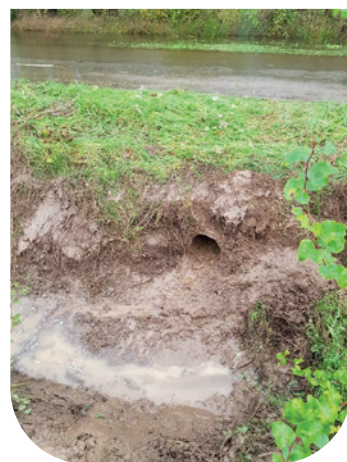
Travaux rue des Parnards
