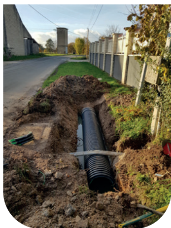
Travaux rue de Chavenne
