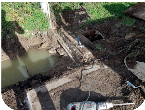
Travaux rue de Chavenne
